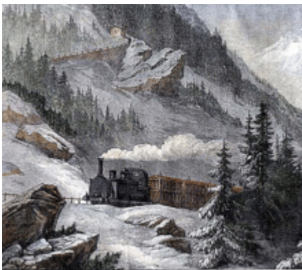
La ferrovia del Moncenisio
